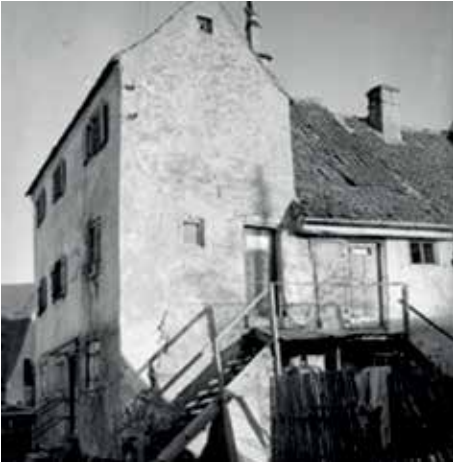
Haus an der Bergstraße vor 100 Jahren
