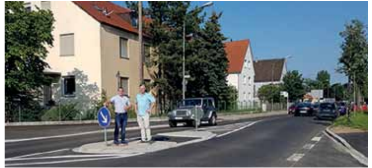
Die neue Fußgängerinsel am Kobelweg, Kreuzung Dumlerstraße
