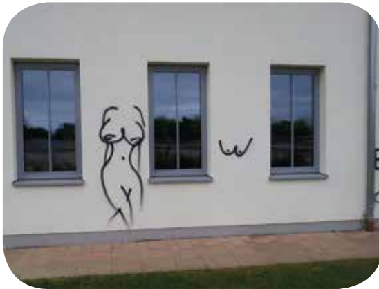
Schmierereien an den Wänden...
