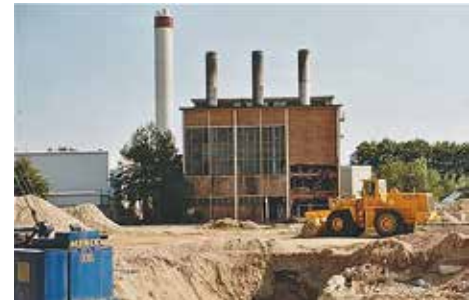
Das alte Kohleheizwerk in der Quartermaster Kaserne (rechts) und das neue Gasheizwerk der Stadtwerke Augsburg links daneben.*
