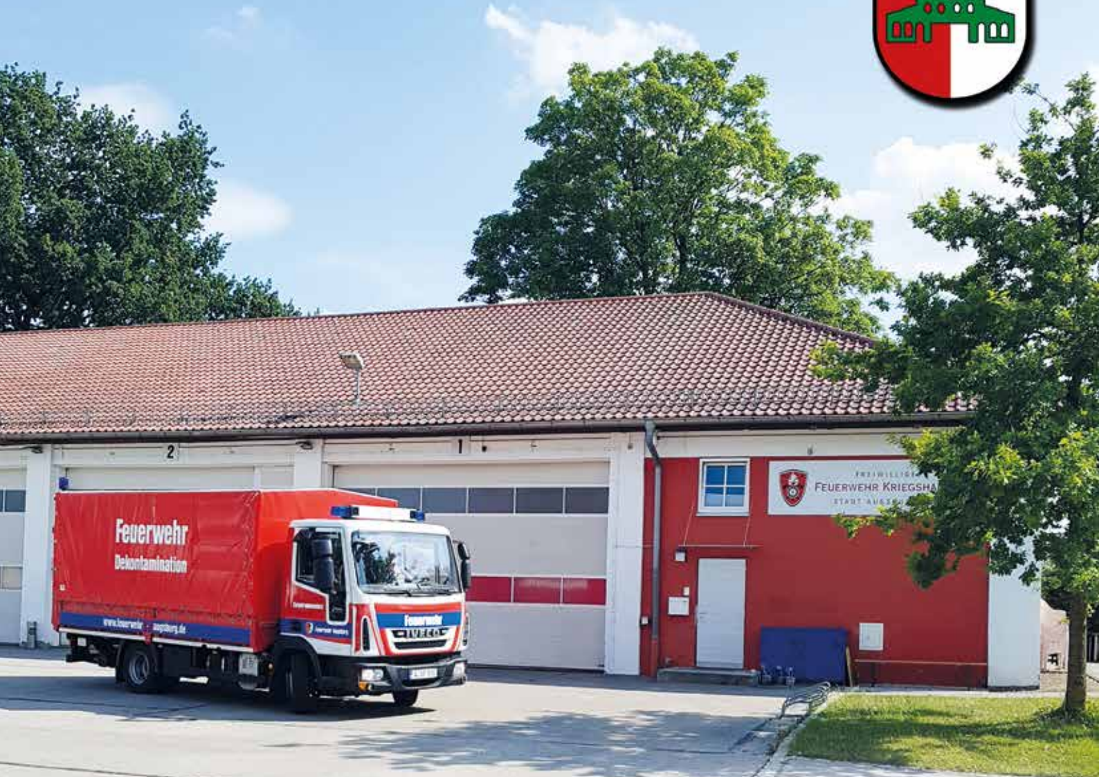
Feuerwache der Freiwilligen Feuerwehr Kriegshaber in der Max-von-Laue-Straße im Nordwesten des Stadtteils.
