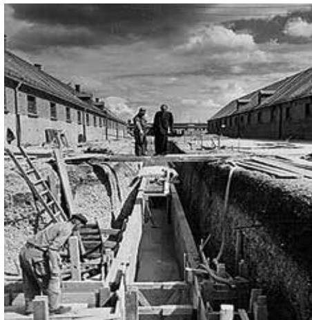
Die U.S. Army erweiterte ihr Fernwärmenetz bereits Anfang der 1950er Jahre von der Reese-Heizzentrale zu anderen Gebäuden in der ehemaligen Somme-Kaserne. Hier der Bau eines Rohrtunnels (Foto: Reise House).*
