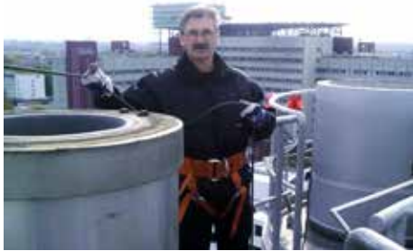
Peter Baumgartner während den Arbeiten an einem Turmkamin
