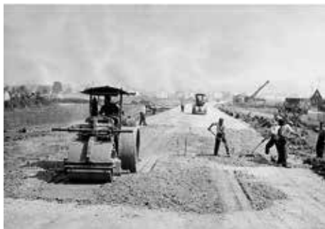
Bau der Nord-Süd-Straße (Vogesenstraße) Foto: Asphalt- und Teerstraßenbau GmbH
